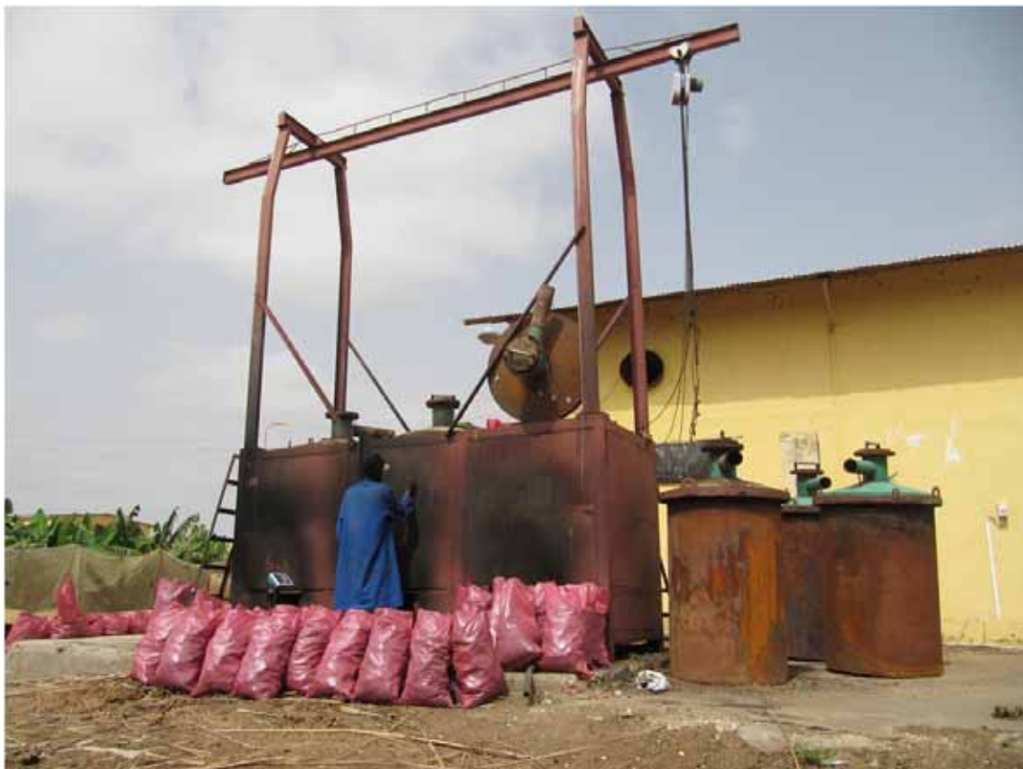
36. Vue d'ensemble du carbonisateur « 3 pots » avec son palan électrique de l'Iset de Rosso
