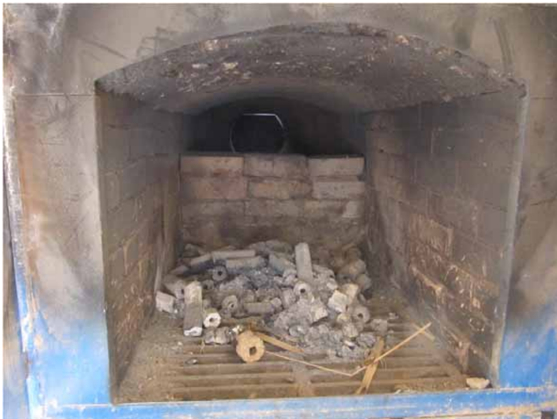
15 : Foyer de combustion du séchoir rotatif avec le cylindre dans le prolongement
