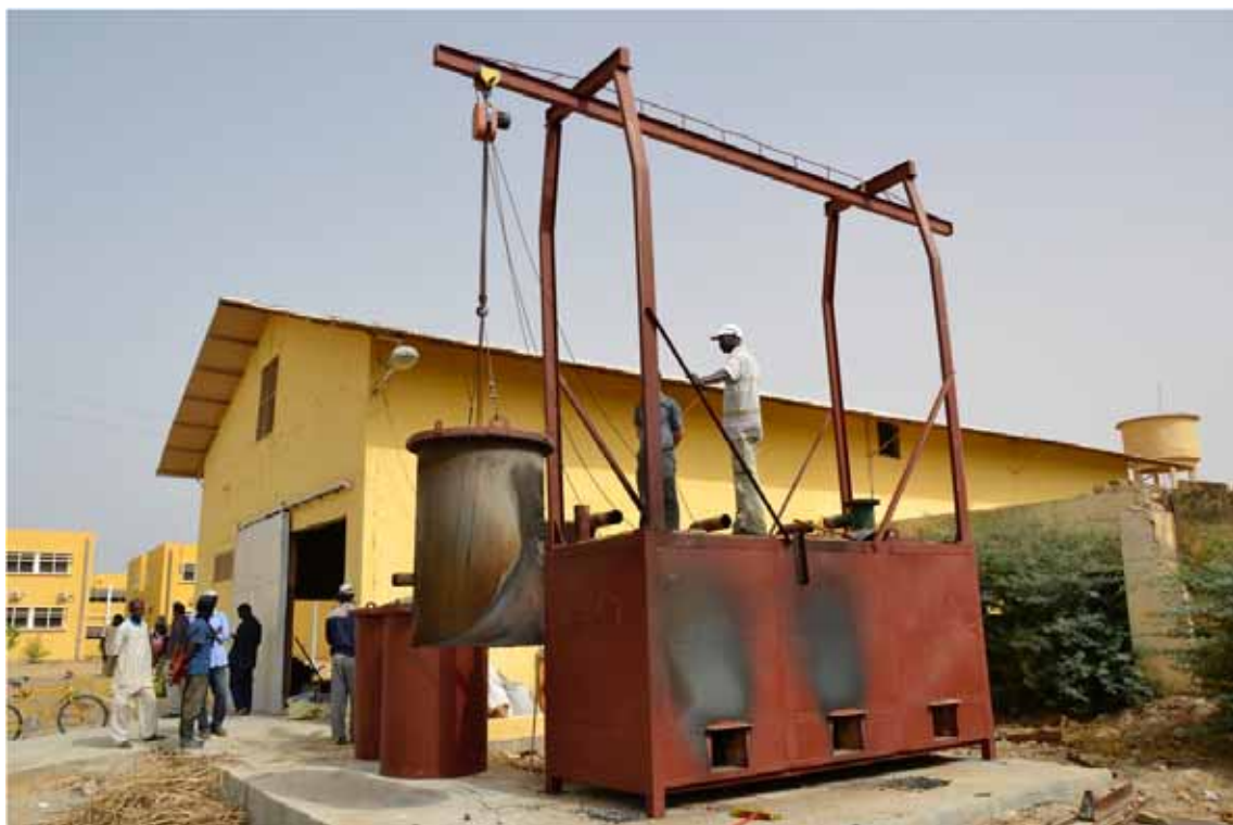
37 : Utilisation du palan pour descendre un des pots
