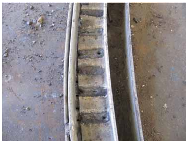
22. Goulotte (en dessous) avec la cornière gauche qui crée le jeu et la cornière droite pour le couvercle
