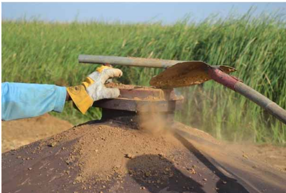
12. Fermeture hermétique du chapeau du carbonisateur
