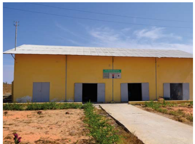
Unité de production semi-industrielle de charbon de Typha à l'Iset de Rosso
